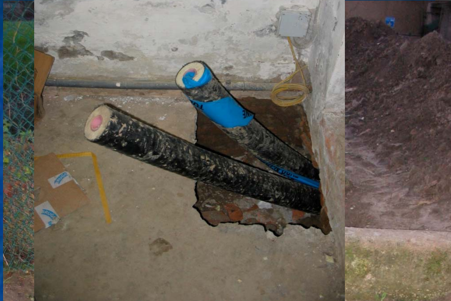
Posa tubazioni pre-isolate
