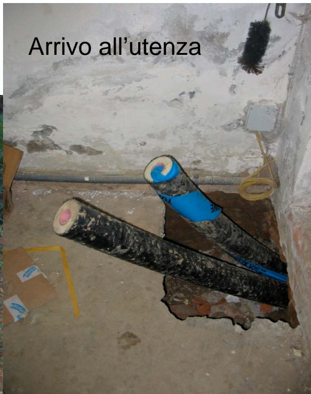
Posa tubazioni pre-isolate
